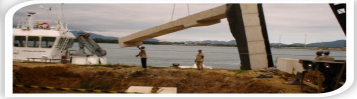
Execução de obras portuárias – Capitania dos Portos de São Paulo – Santos – SP
